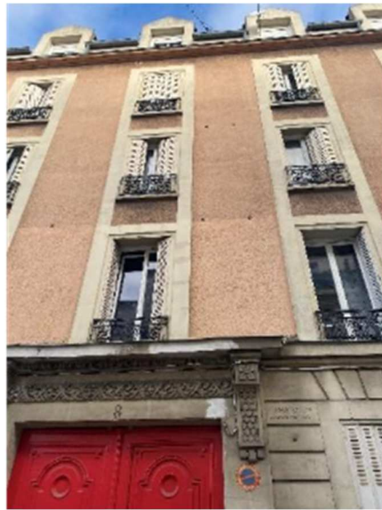
Figure 44 : Bâtiment Aubert, source ACTELOS
