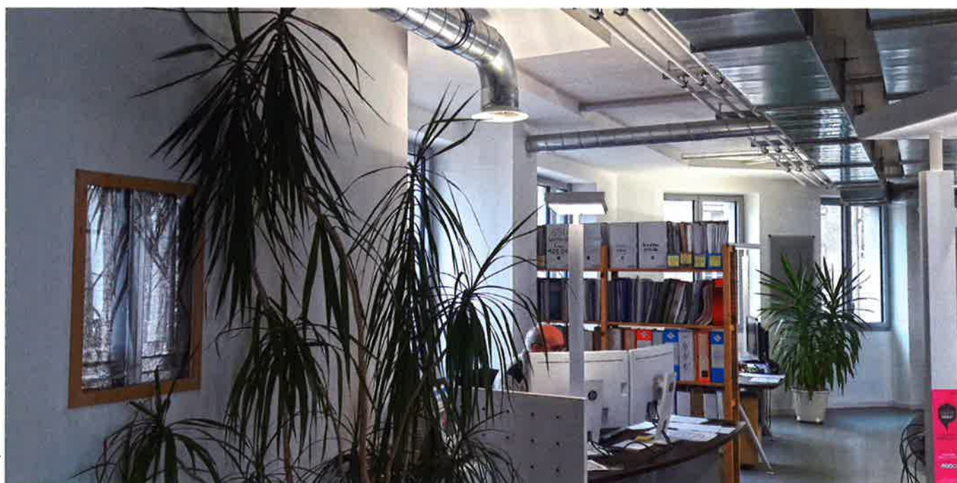
Dans les locaux du cabinet Pouget Consultants, la ventilation s'ajuste en temps réel si la présence d'une personne est détectée. Idem pour l'éclairage.
