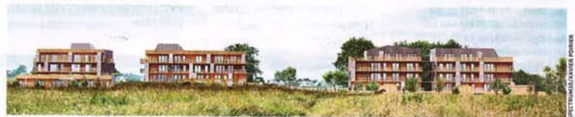
Le programme Osmoz (41 logements collectifs et trois maisons individuelles groupées) se fond dans le paysage, sur un site idéal en pente douce.
