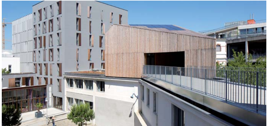
La densification du bâtiment participe à sa performance. Deux ajouts ont été réalisés sur le bâtiment existant. Leur toiture supporte les capteurs solaires photovoltaïques.
