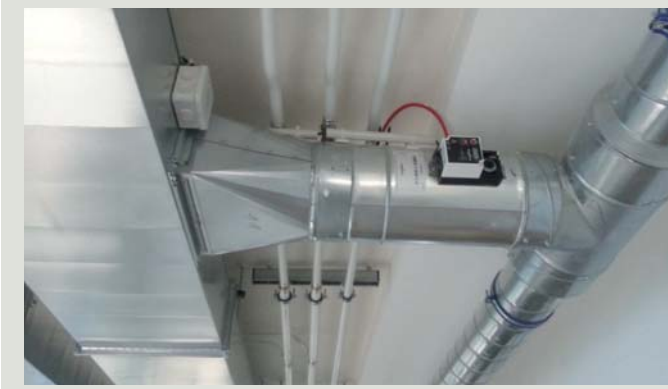
La diffusion de chaleur est assurée par l'air, complété par quelques radiateurs à chaleur douce (basse température). La ventilation double flux Everest d'Aldes souffle de l'air neuf modulé en fonction du taux de CO 2 détecté. Les gaines de ventilation ont été laissées visibles à l'intérieur.
