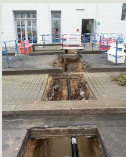
Le chauffage et l'eau chaude sanitaire sont fournis par branchement sur le réseau de chauffage urbain issu à 80 % d'énergies renouvelables. Une sous-station de seulement 40 kW a été créée pour l'occasion, l'exploitant ne raccordant habituellement qu'un minimum de 100 kW.
