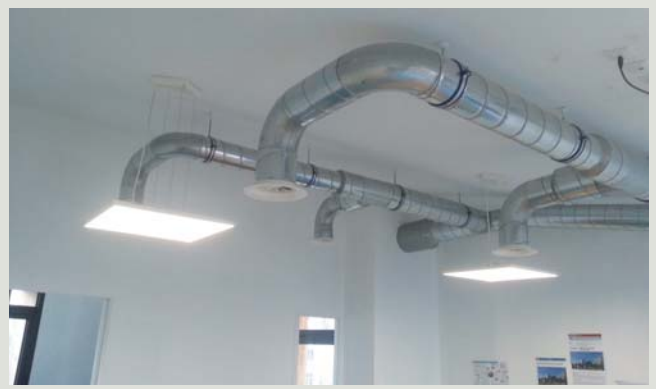
La diffusion de chaleur est assurée par l'air, complété par quelques radiateurs à chaleur douce (basse température). La ventilation double flux Everest d'Aldes souffle de l'air neuf modulé en fonction du taux de CO 2 détecté. Les gaines de ventilation ont été laissées visibles à l'intérieur.
