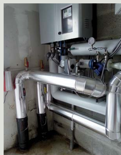
Le chauffage et l'eau chaude sanitaire sont fournis par branchement sur le réseau de chauffage urbain issu à 80 % d'énergies renouvelables. Une sous-station de seulement 40 kW a été créée pour l'occasion, l'exploitant ne raccordant habituellement qu'un minimum de 100 kW.
