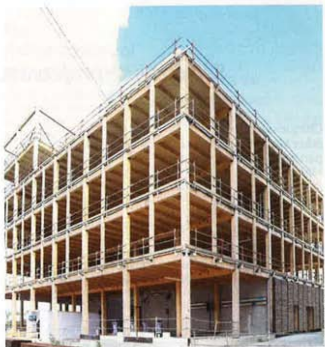
L'ossature bois, réalisée avec du pin maritime, restera apparente à l'intérieur de l'immeuble Perspective.
