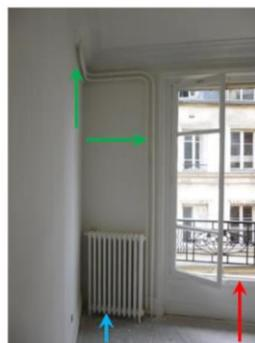
Photo : Attention : création appui précaire possible ; Colonnnes montantes au mur et suivant le décroché Radiateur posé au sol
